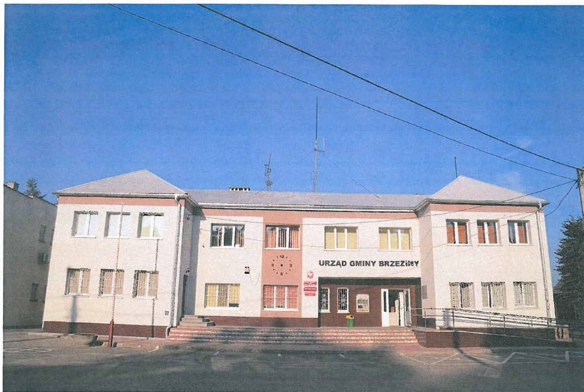
Fotografia nr 2. Budynek Urzędu Gminy Brzeziny Źródło własne.
