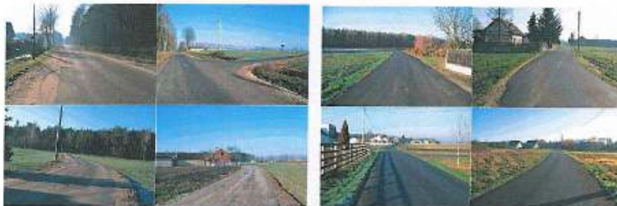
Zadanie pn. „Przebudowa nawierzchni drogi gminnej w miejscowości Jagodziniec, gm. Brzeziny”
