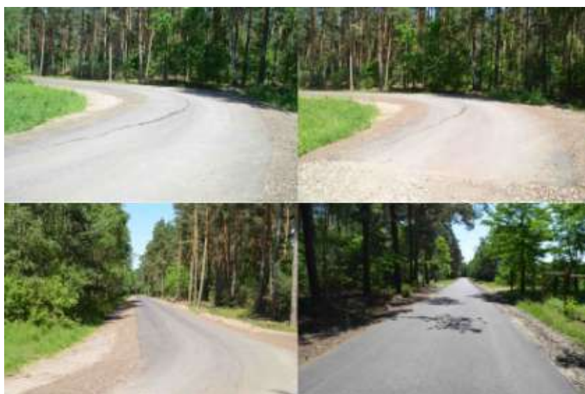
Przebudowa drogi leśnej udostępnionej do ruchu publicznego we wsi Jamnice
