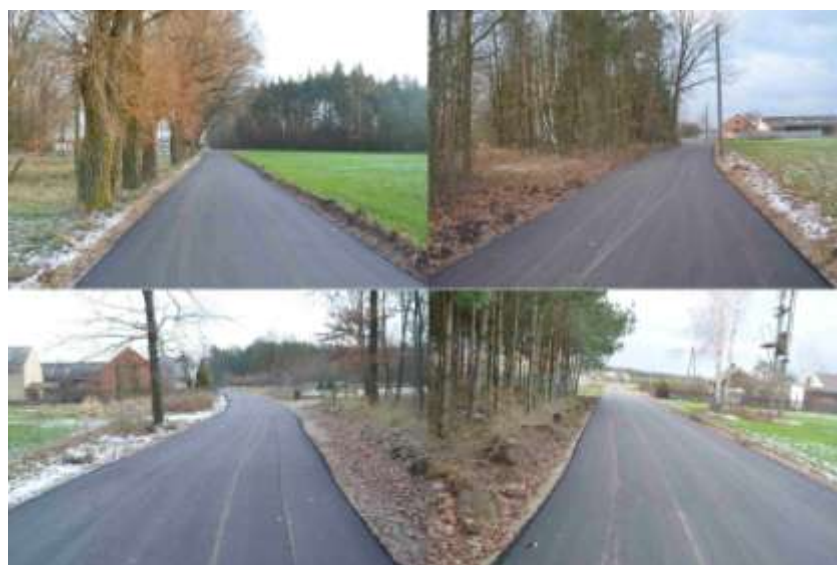
Przebudowa drogi gminnej w m. Czempisz – Zaleśna gm. Brzeziny
