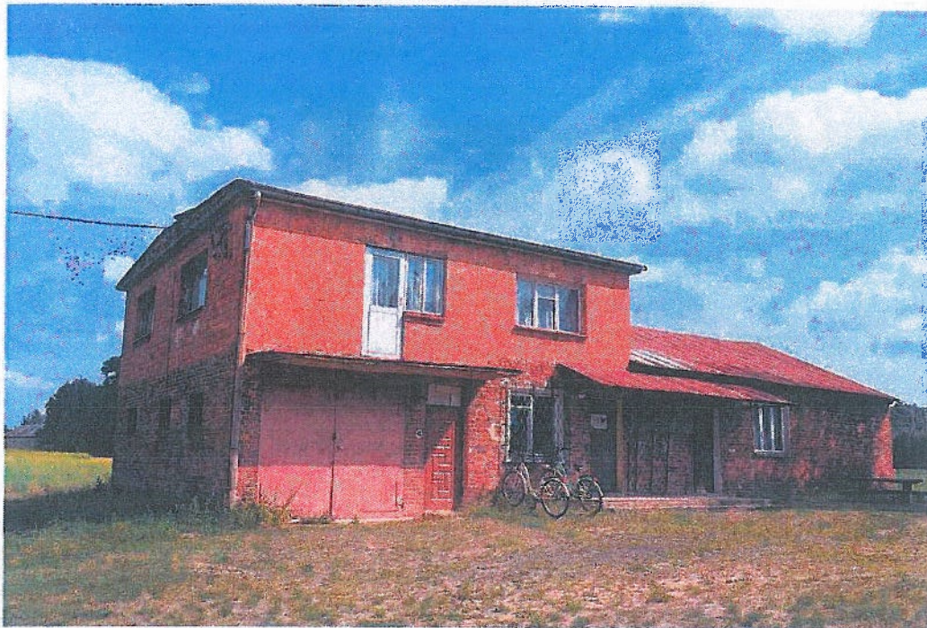
Budynek Ochotniczej Straży Pożarnej w Przystajni Kolonia
