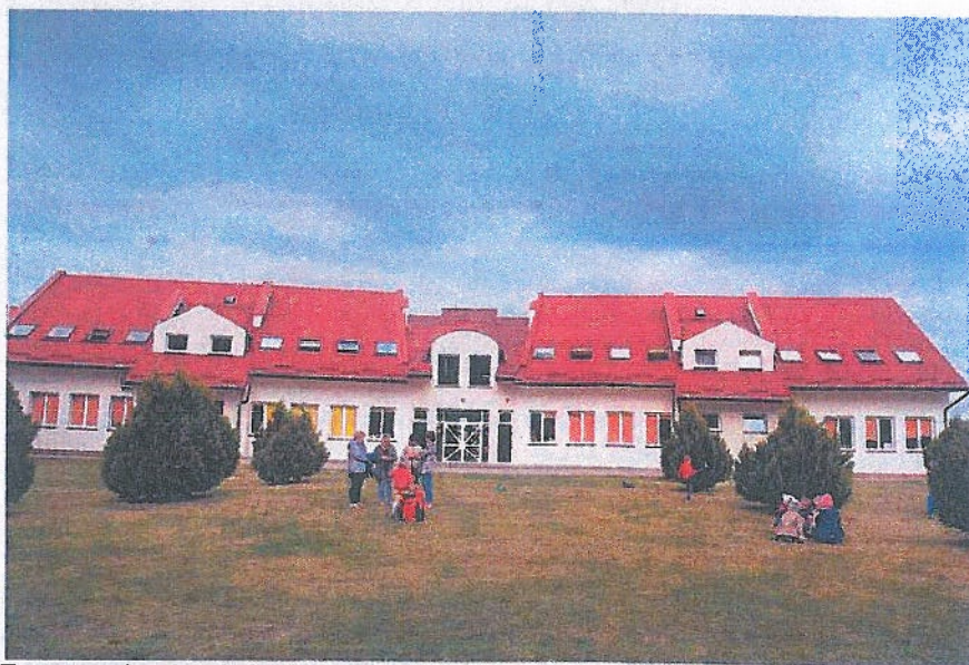
Termomodernizacja budynku Gimnazjum w Brzezinach
