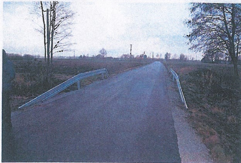
Przebudowa drogi gminnej w miejscowości Jamnice
