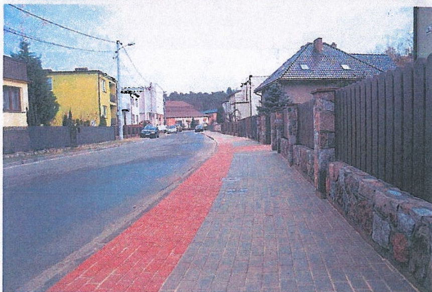
Przebudowa chodnika na ulicy Marszałka Józefa Piłsudskiego na działce nr 76 w Brzezinach
