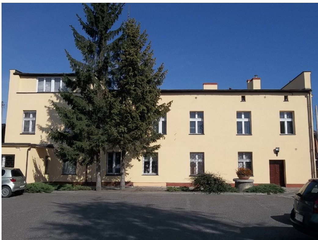
Fot.2 Elewacja tylna
