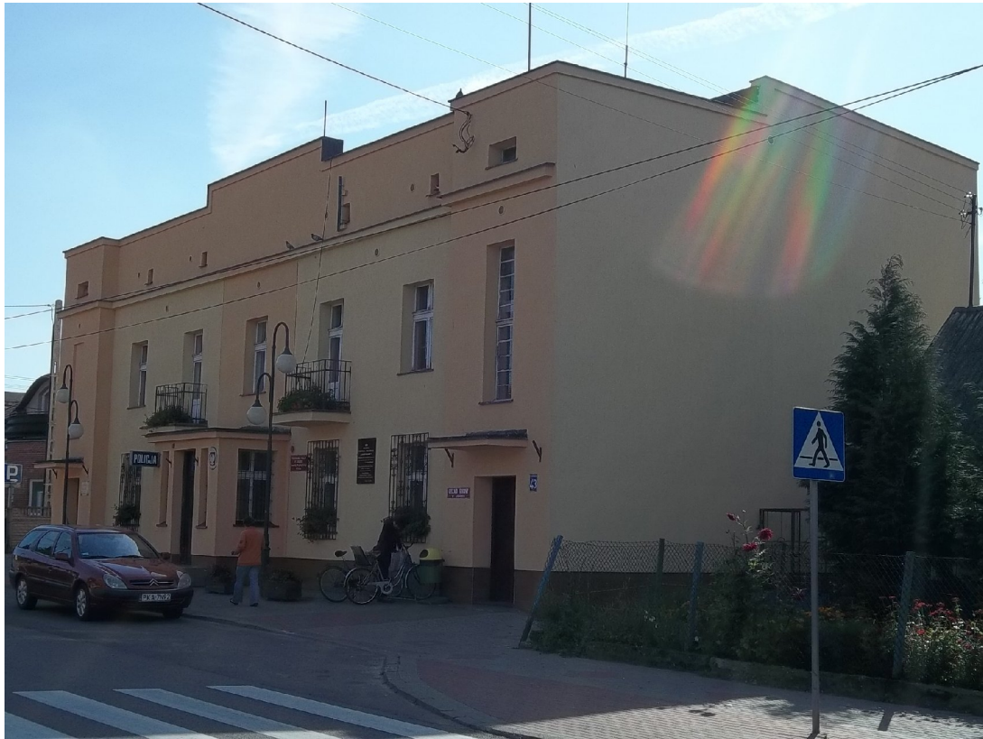
Fot.3 Elewacja frontowa i boczna
