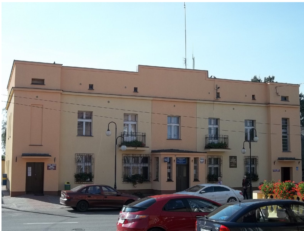
Fot.1 Elewacja frontowa
