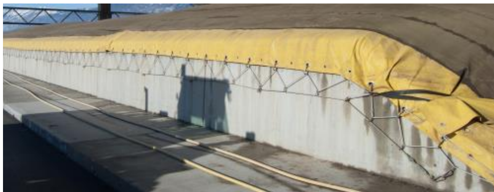
Rysunek 2. Mocowanie membrany za pomocą ściągu (Źródło: materiały własne)
