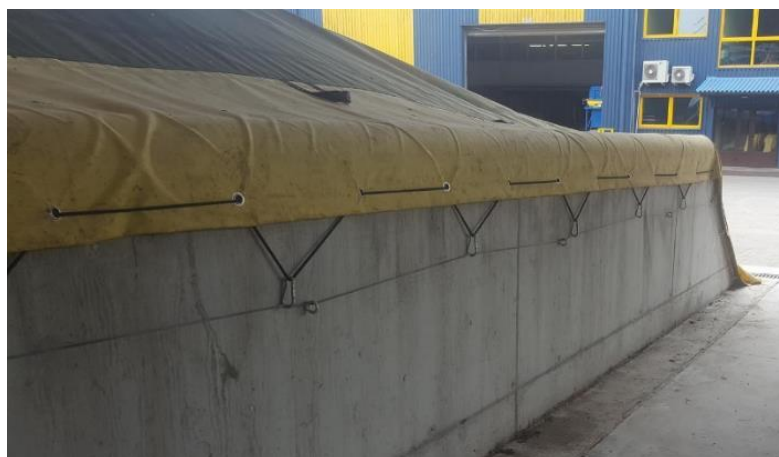
Rysunek 3. Mocowanie membrany za pomocą karabinków (Źródło: materiały własne)
