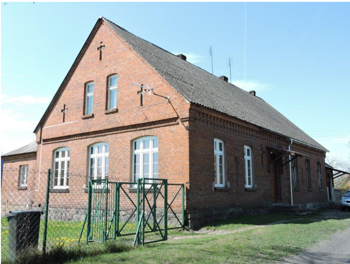
Rysunek 25 Wymagająca remontu sala wiejska w Starym Dzierżaniu (źródło: Urząd Gminy Złotów)
