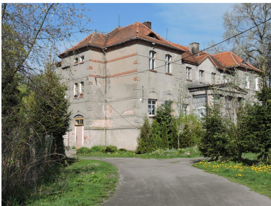
Rysunek 16 Niszczące budynki i zły stan drogi w Bielawie (źródło: Urząd Gminy Złotów)
