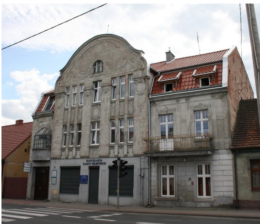
Chodzież, secesyjna kamienica przy ul. Krasińskiego
