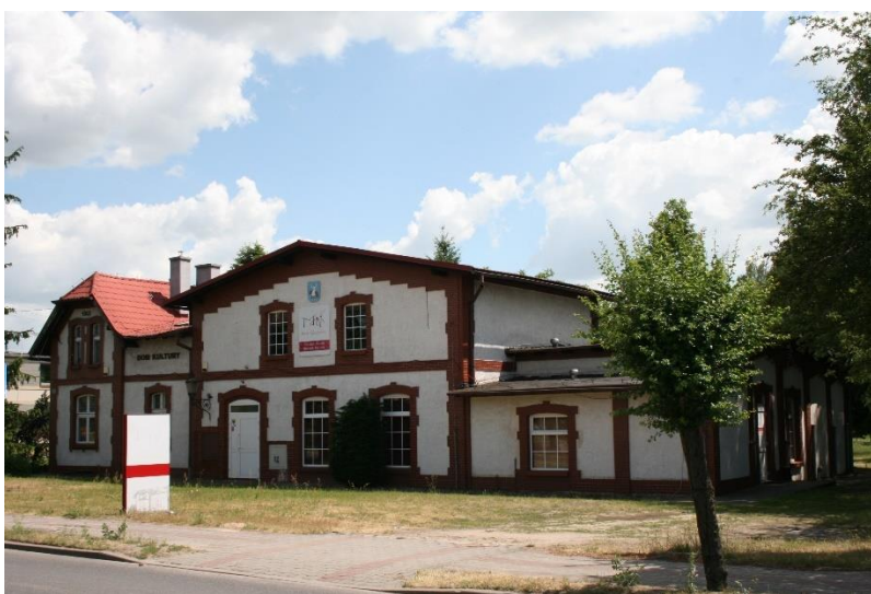
Margonin, budynek dawnej gazowni
