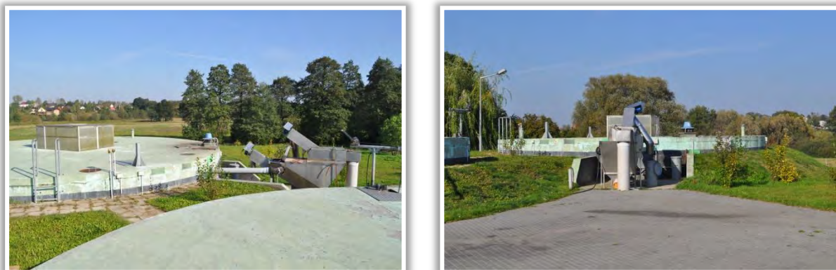
Ryc. 22. Oczyszczalnia ścieków w Jankowie Dolnym
