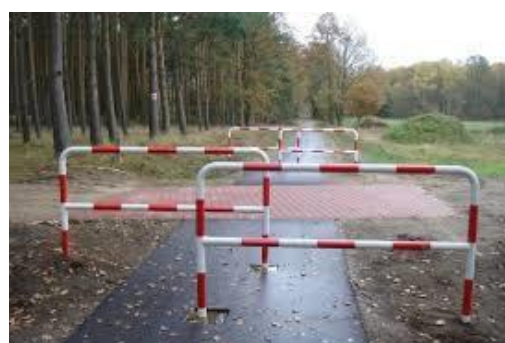
Rysunek nr 49. Barierki ograniczające bezpośredni wjazd na jezdnię
