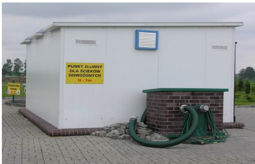
fot.5. Gminna oczyszczalnia ścieków w Rozdrażewie.
