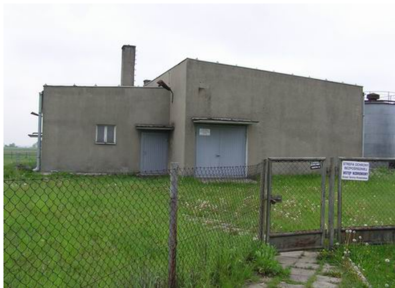
fot.3. Ujęcie wód podziemnych w Dąbrowie.
