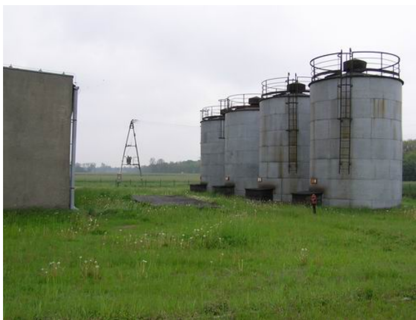
fot.4. Ujęcie wód podziemnych w Dąbrowie.
